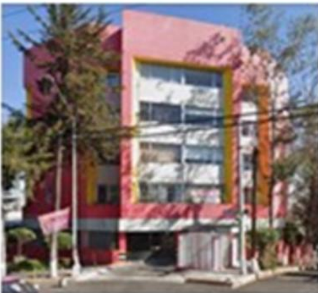
Calzada de los Corceles 300 5 niveles
