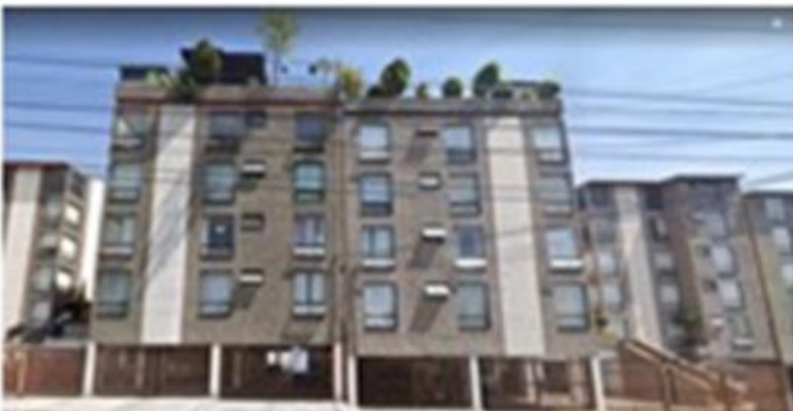
Calzada de los Corceles 115 4 niveles
