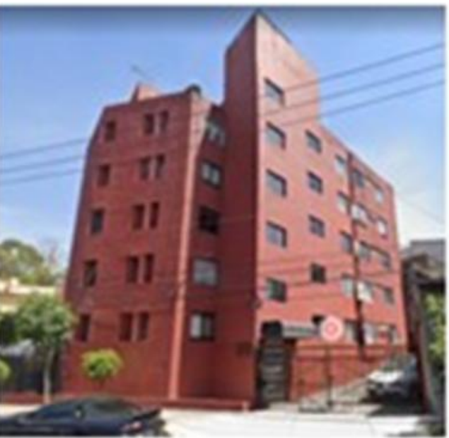
Calzada de los Corceles 1078 5 niveles
