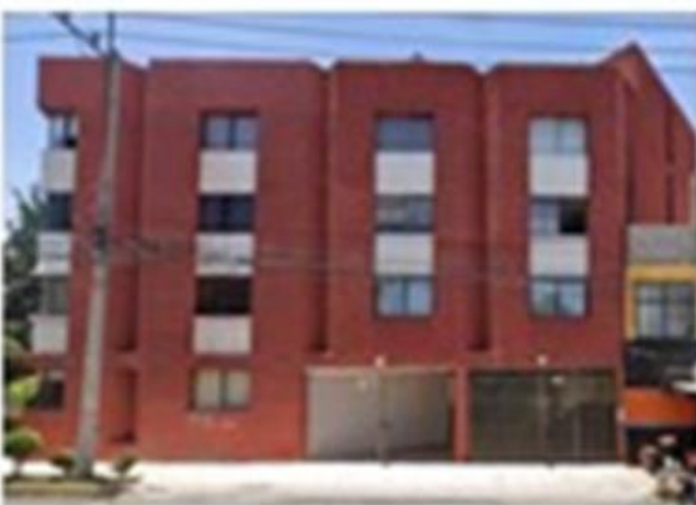
Calzada de los Corceles 1074 4 niveles
