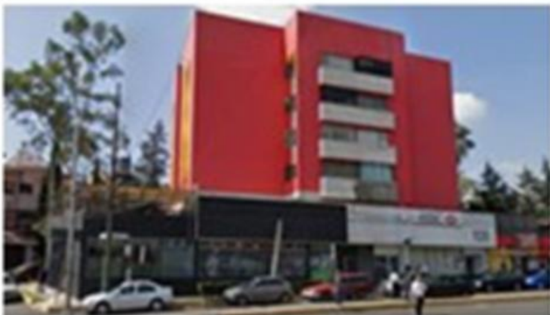
Calzada de los Corceles 1120 5 niveles
