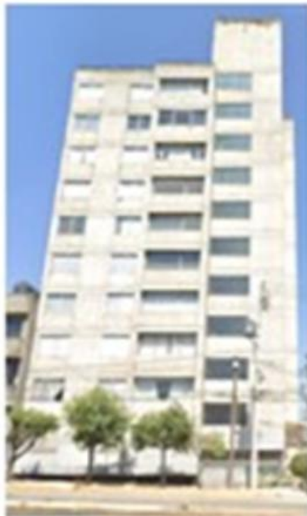
Av. Sta. Lucia 957 10 niveles
