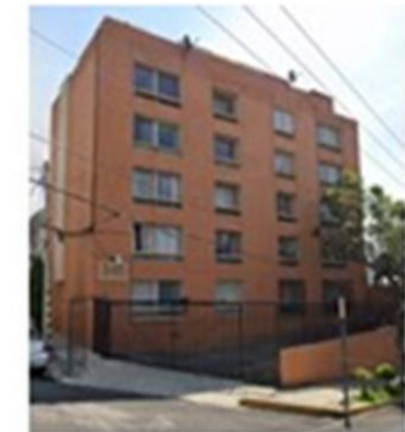
Calzada de los Corceles 245 5 niveles
