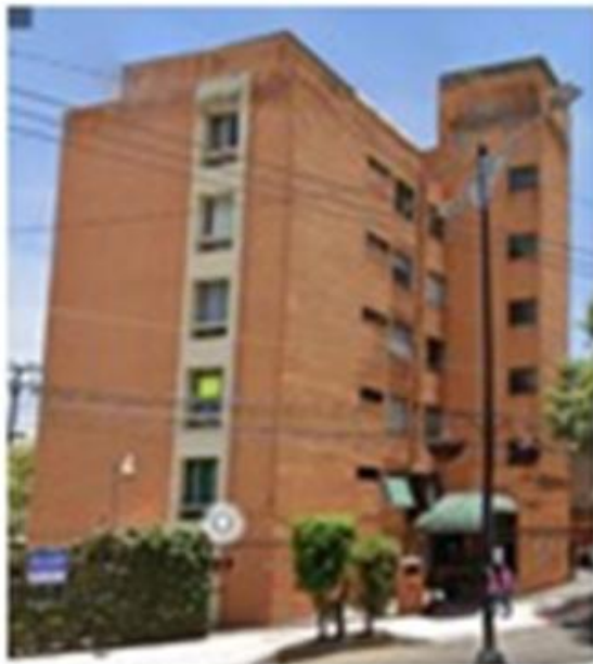
Av. Sta. Lucia 994 6 niveles
