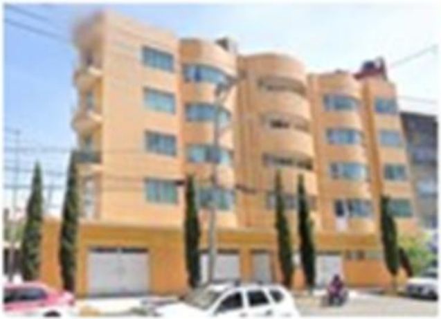
Calzada de los Corceles 1060 4 niveles
