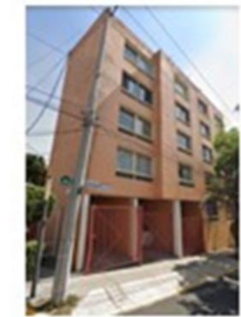
Calzada de los Corceles 245 5 niveles
