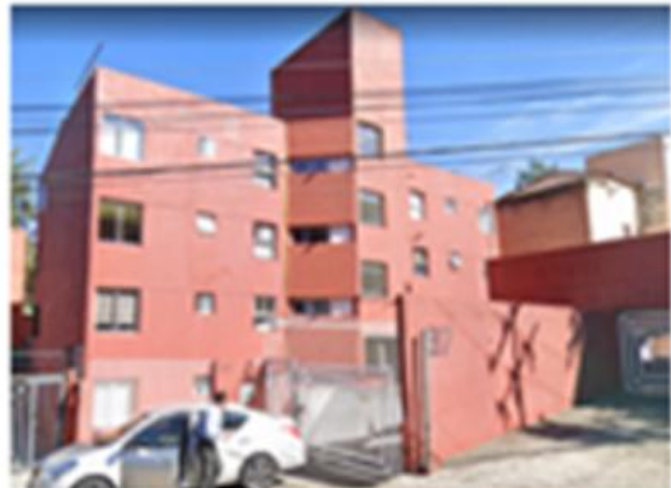
Calz. de las Arcadas 97 4 niveles
