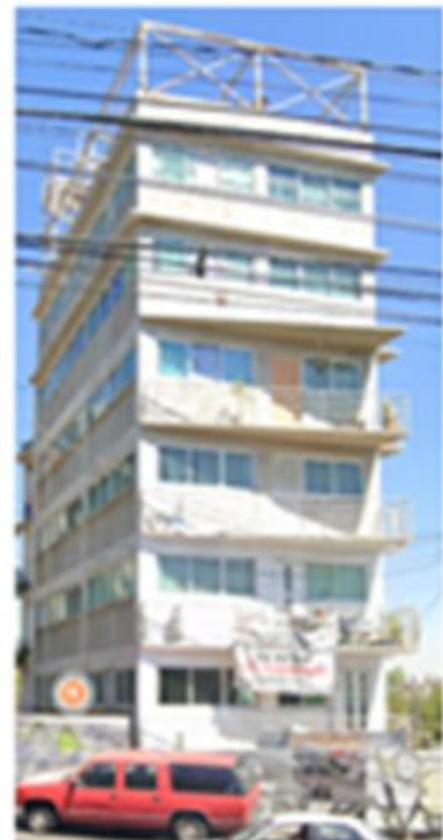
Av. Centenario 1080 6 niveles
