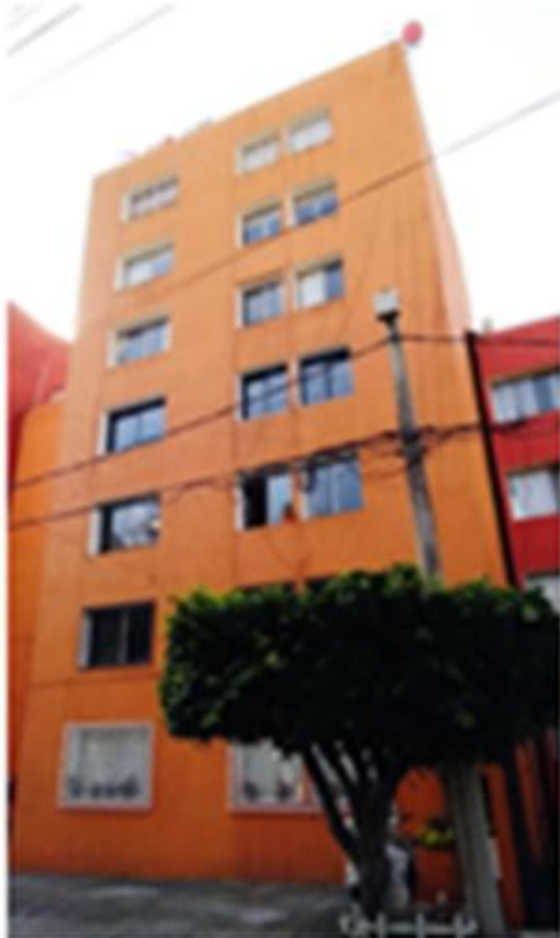
Rinconada Centenario 36 7 niveles
