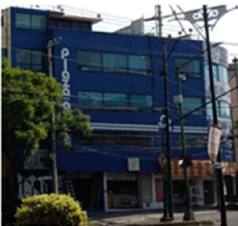
Av. Centenario 1100 4 niveles
